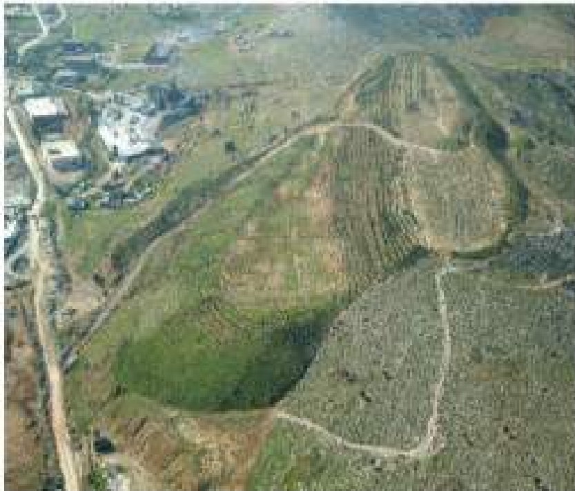
Επιαναφορά αρχικού ανάγλυφου – ανάπλαση περιβάλλοντος παλαιού λατομικού χώρου από ΕΛΛΗΝΙΚΑ ΛΑΤΟΜΕΙΑ ΑΕ.
